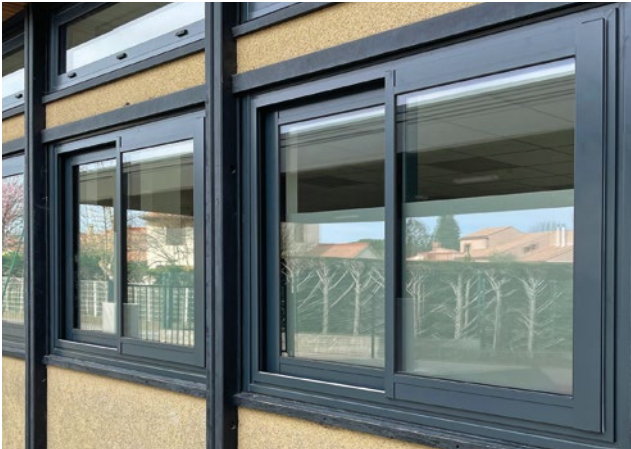
De nouvelles menuiseries
