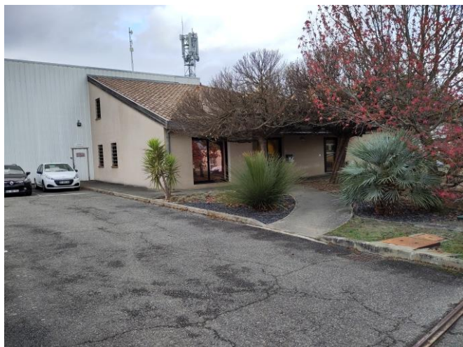
Bâtiment de bureau
