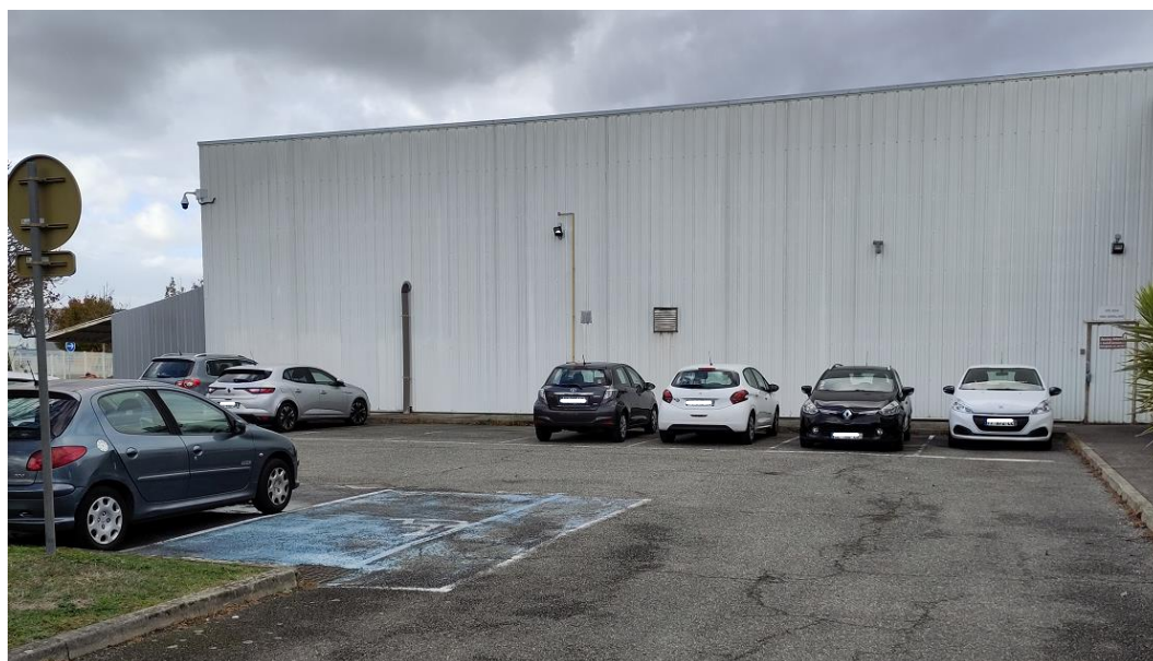
Photos du parking pour implantation de l'ombrière
