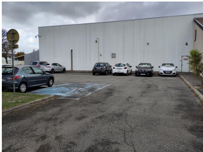
Emplacement de l'ombrière
